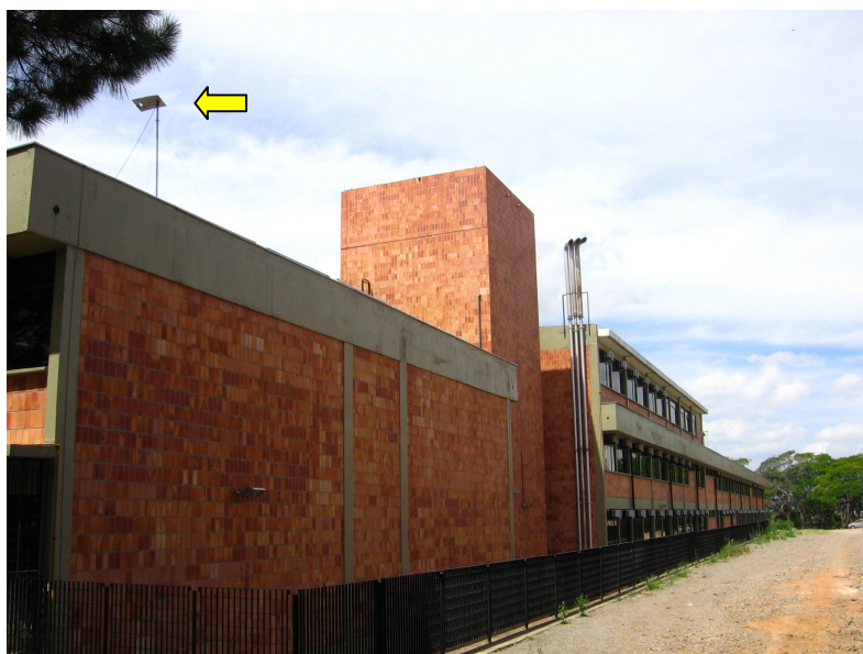
FIGURA 6.4 – Prédio Sede do Centro Regional Sul de Pesquisas Espaciais – CRSPE/INPE - MCT – localizado em Santa Maria - RS. Instalação provisória da Estação (T) do Sistema GPS.
